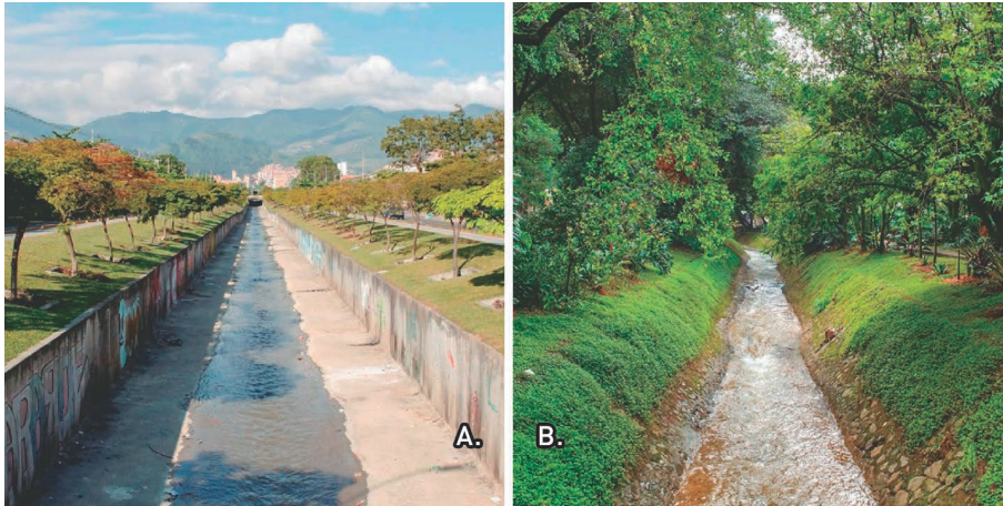
Figuras 7. La canalización de corrientes hídricas asociadas al sistema vial. A) Artificialización, deterioro paisajístico y ruptura de las relaciones fauna-agua en la ciudad, ocasionada por los canales en U. B) Opciones de mayor funcionalidad ecológica (canales en V y en piedra).
